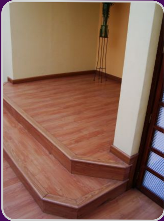
TARIMA PARA DEMOLER Y ABRIR PUERTA PRINCIPAL
