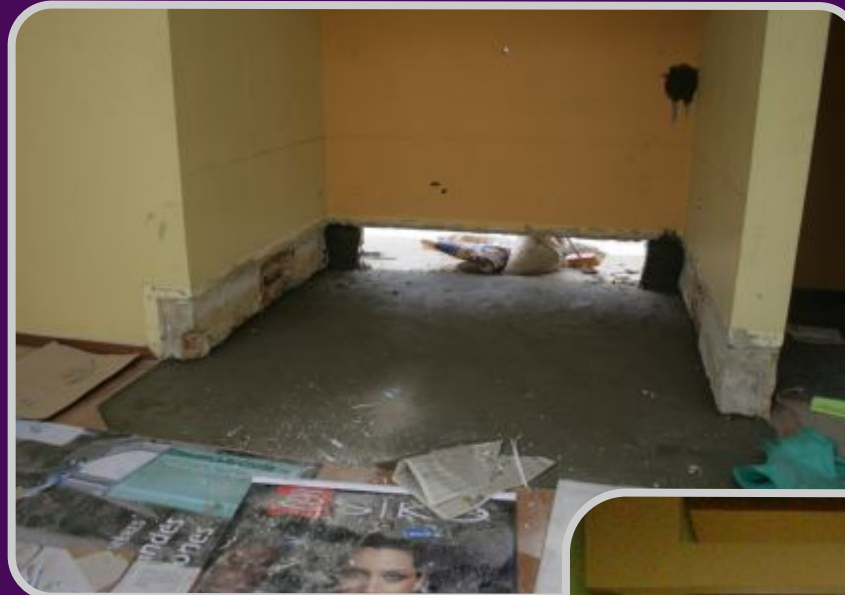
DEMOLICIÓN Y NIVELACIÓN DE PISO CON MORTERO DE 5CM.
