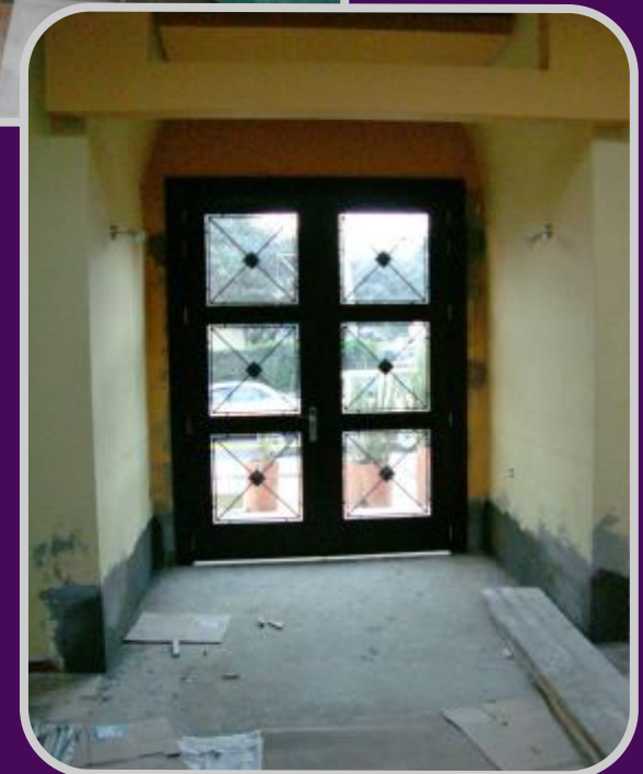
APERTURA DE NICHOS EN PARED E INSTALACIÓN PUERTA PRINCIPAL
